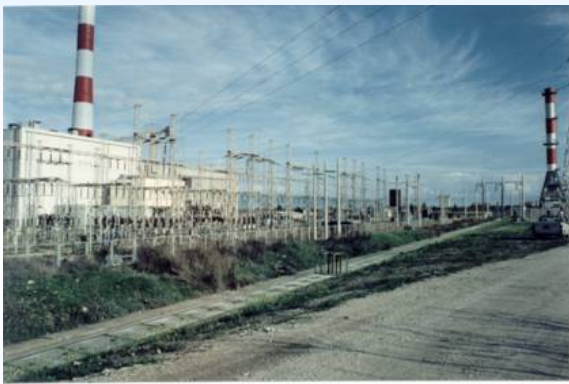
Σταθμός Σορωνής, ΡΟΔΟΣ
